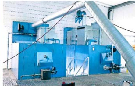
Der Ofen erstreckt sich auf mehreren Etagen mit großen Rohren und Filtern.
